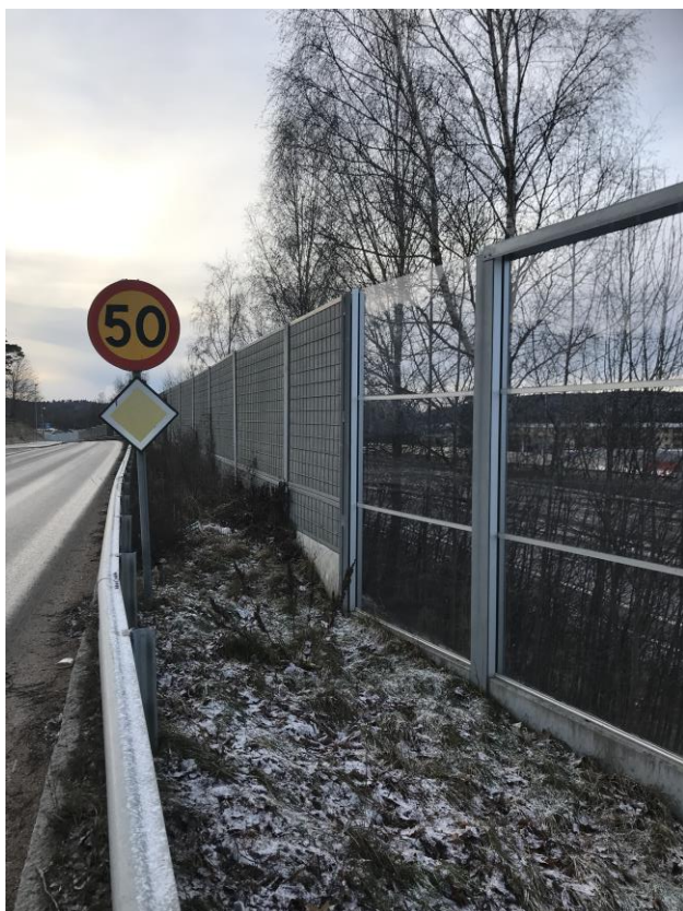
Figur 6 Bullerskyddsskärm söder om väg E20 och längs Södra Långvägen med reflekterande parti (förgrunden) och absorberande parti (bakgrunden)
